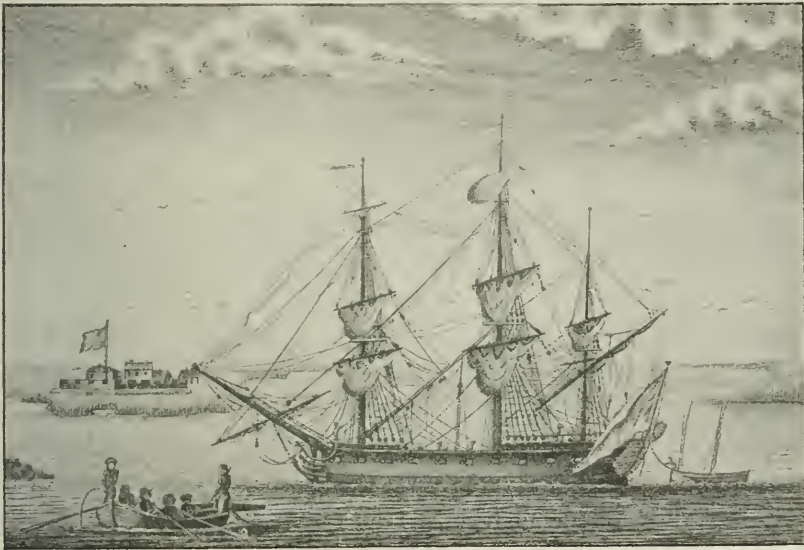
VUE DU FORT DE LA BALISE
